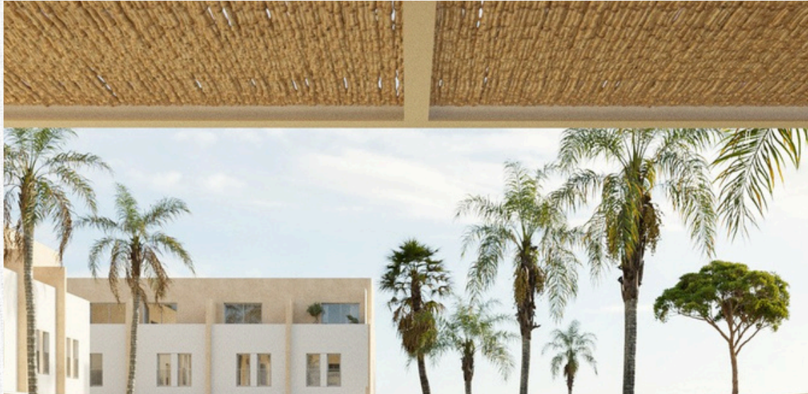
Pérgola metálica cubierta de cañizo
