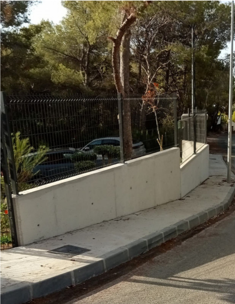
Muros exteriores de hormigón visto + valla Exposed concrete exterior walls + fence
