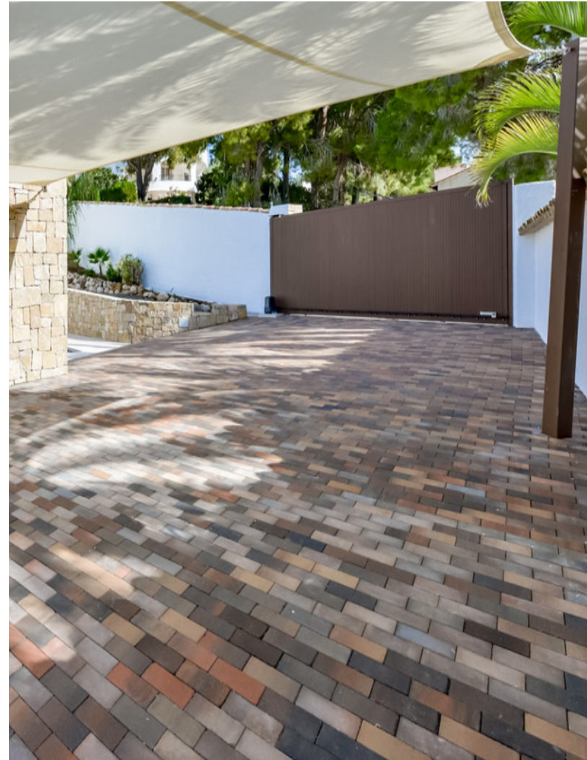
Pavimento de adoquín Cobbleston pavement
